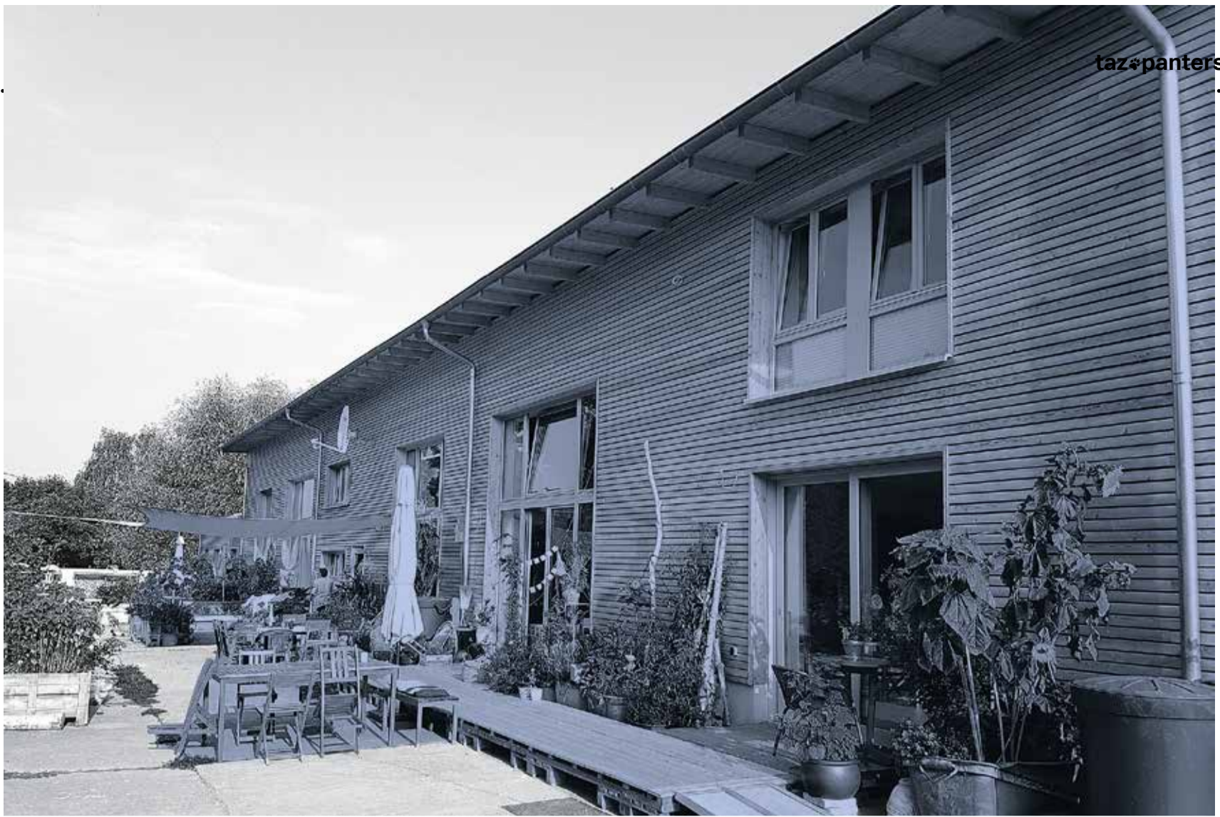
Baumhaus Weimar, eine ehemalige Werkstatt für Landmaschinen, die in ein Wohngebäude verwandelt wurde Foto: Torsten Haag
